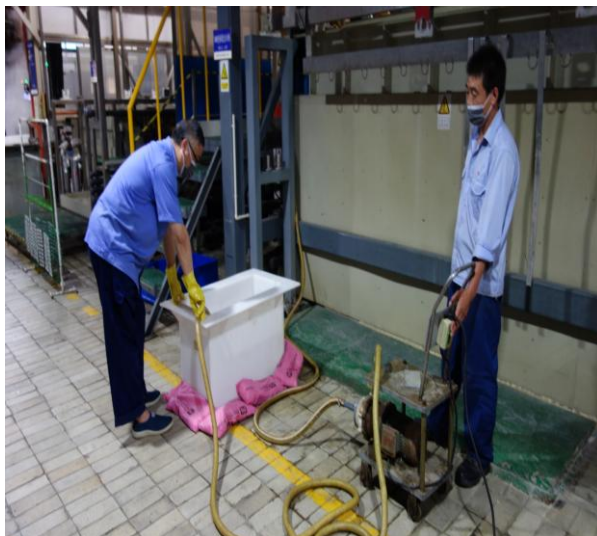
2.转移渗漏镀槽溶液。
