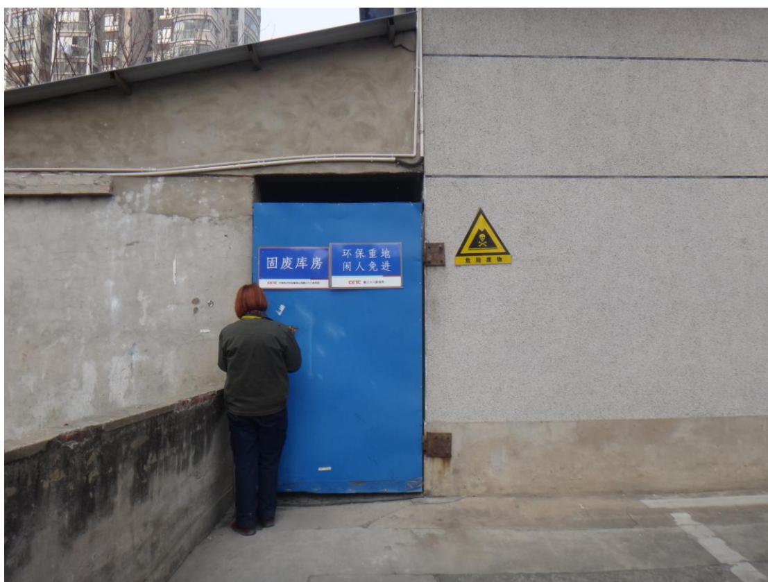
危险废物暂存库规范化管理照片
